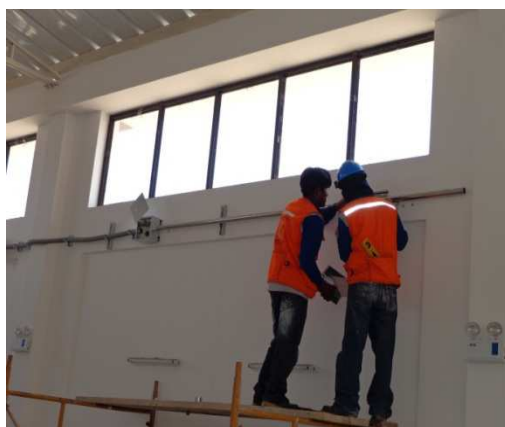
Trabajos de adecuación Centro de Producción
